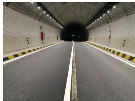
图6 现场灯具安装效果及照明效果
